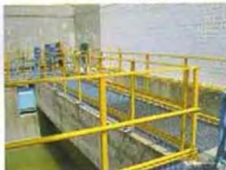
Tratamento de esgoto (ETE)
