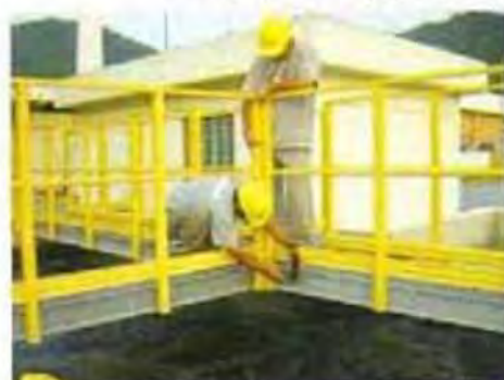
Tratamento de efluentes
