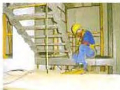
Instalação de Estrutura
