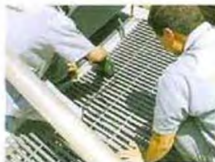
Instalação de Grade de Piso
