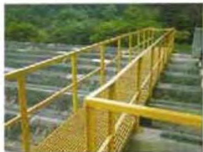
Guarda-corpos instalados
