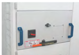
na posição garras de força e comando inserida.
