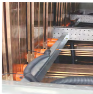
Suporte horizontal fixado nos perfis laterais
