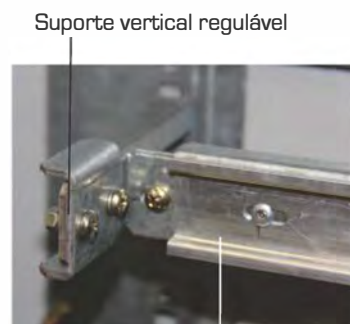
Suporte Horizontal com perfil DIN para fixar disjuntores bornes.
