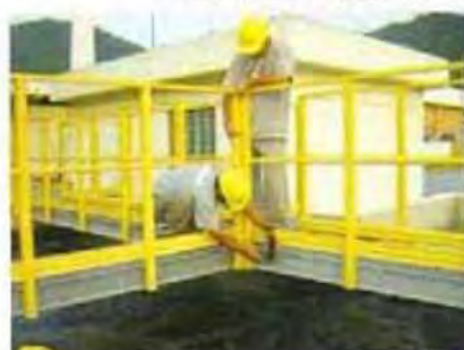
Tratamento de efluentes
