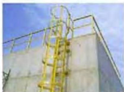
Escada Marinhoiro instalada
