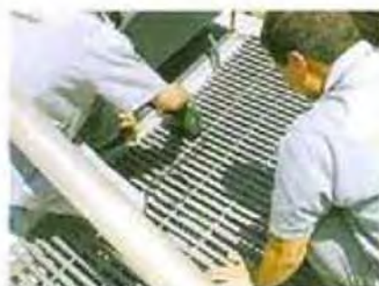
Instalação de Grade de Piso
