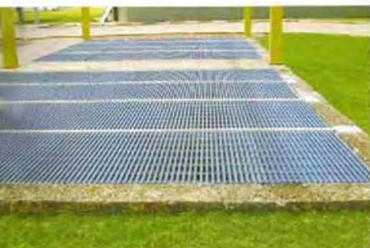
Grades de piso instalada - ETA
