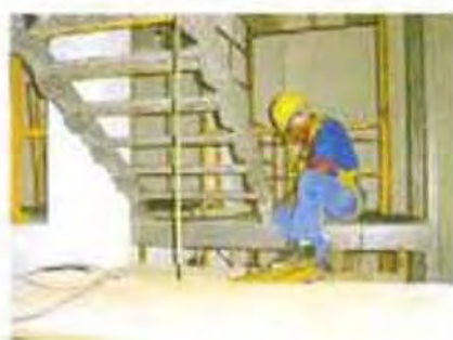
Instalação de Estrutura
